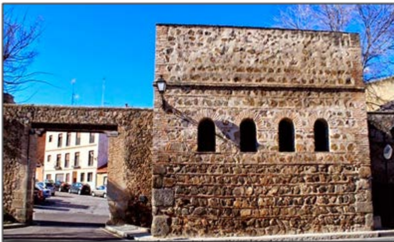
Vista exterior de la Puerta del Vado. Realmente lo que vemos es la parte superior de la puerta. Desde este nivel hay que bajar casi 9 metros para encontrarnos la puerta original
